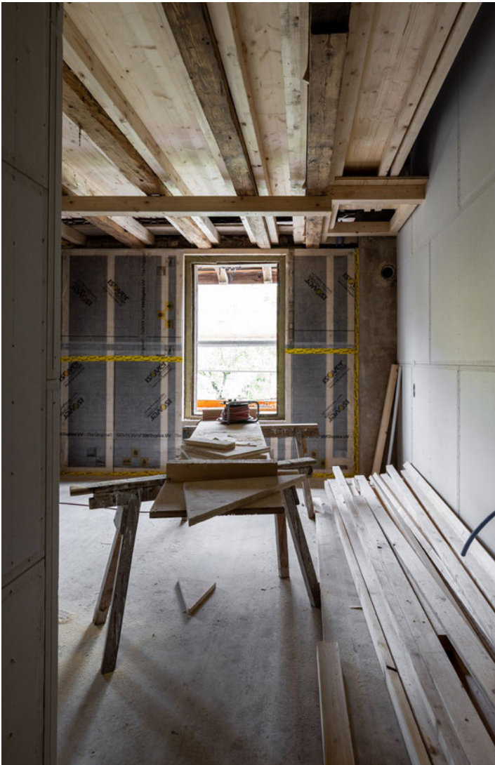
Bilder vom Knopfliweg 6 vor, während und nach dem Umbau (1. Obergeschoss und Dachgeschoss).
