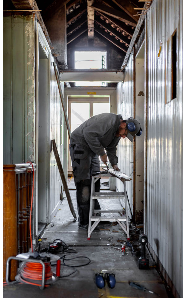
links unten: Abbruch der Decken- und Wandverkleidungen am Knopfliweg 4. Die alte Bausubstanz kommt zum Vorschein.
