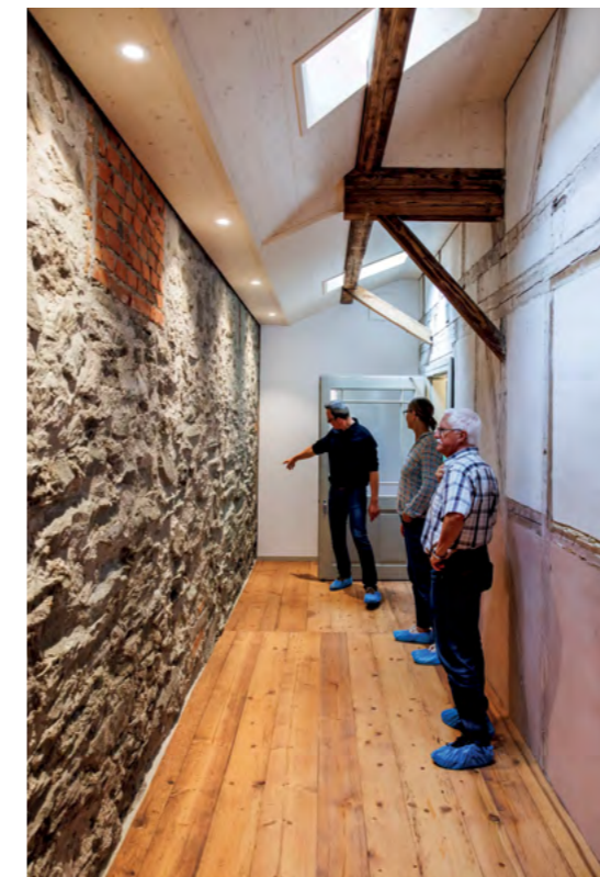
Besichtigung der sanierten Liegenschaft am Knopfliweg in Zug im Juni 2025.
