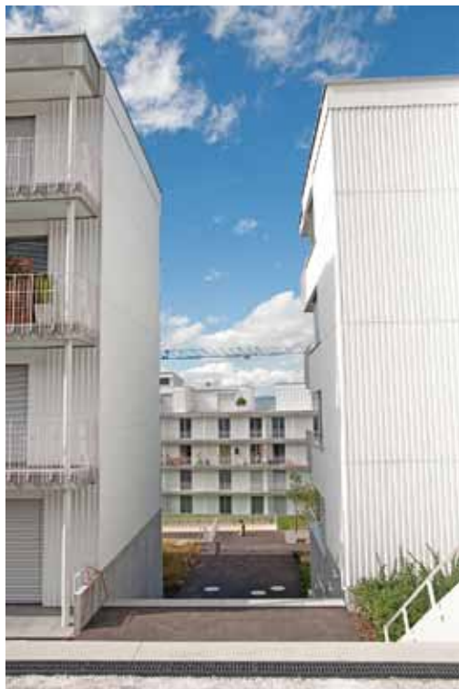
Die Welleternitfassade verleiht den Häusern eine gewisse Leichtigkeit.
