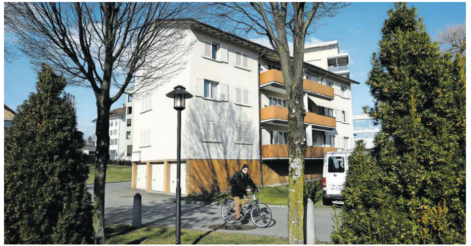
Das im Jahr 1959 erstellte Haus an der Goldermattenstrasse 25 in Steinhausen soll Anfang 2019 rückgebaut und durch einen Neubau mit Kleinwohnungen ersetzt werden.
