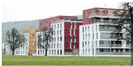
Die Wohnungen an der Eichwaldstrasse in Zug wurden von der Wohnbaugenossenschaft Familia Zug gebaut. Die Mieter profitieren von der Kostenmiete. Bild: DF
