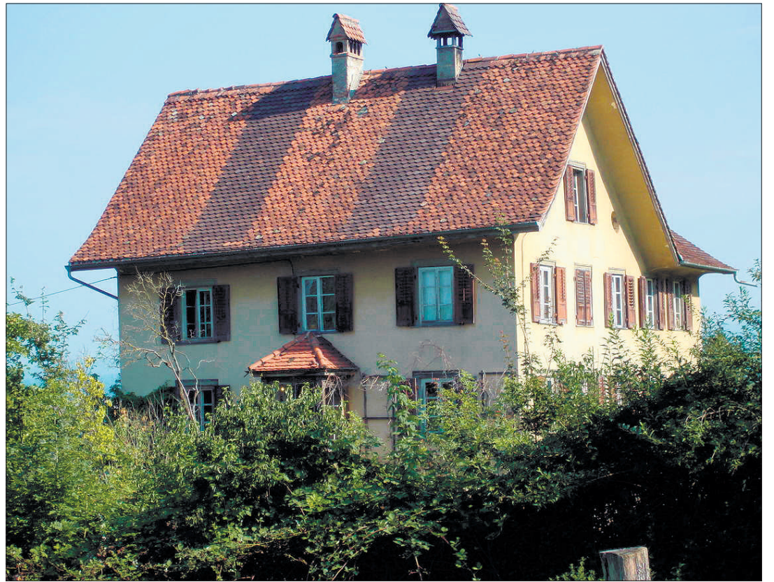
Wird bald abgebrochen: das Haus Oberer Roost im Süden der Stadt.
