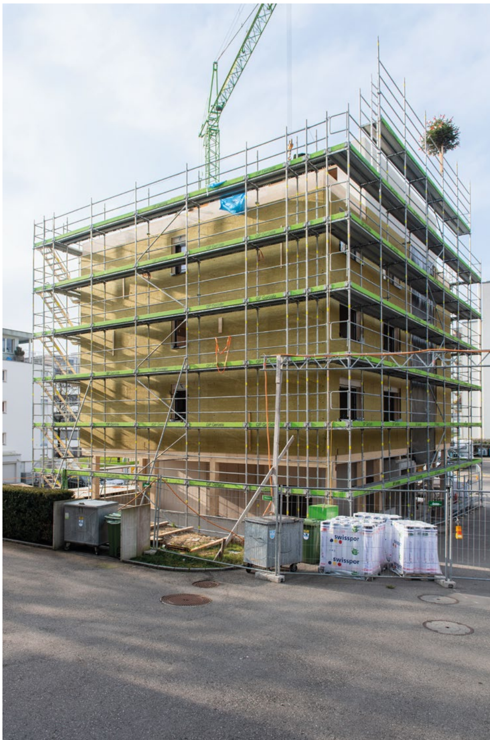
Bilder: Neubau Goldermattenstrasse, Steinhausen (13.1.2020)
